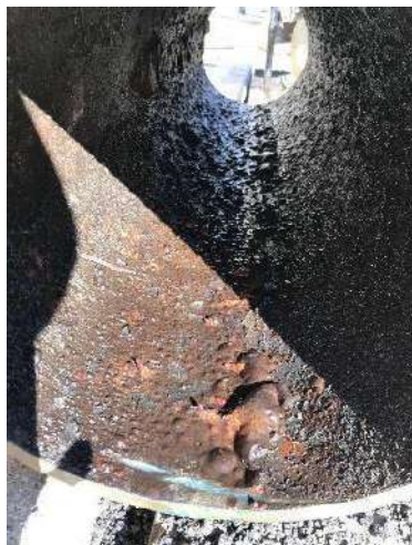
Etat de la conduite avant nettoyage
