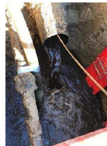
Nettoyage de la conduite
