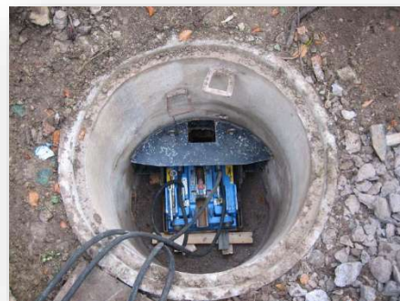
Fig.: Pulling Unit 400 KN, Tracto 400S www.tracto.com
