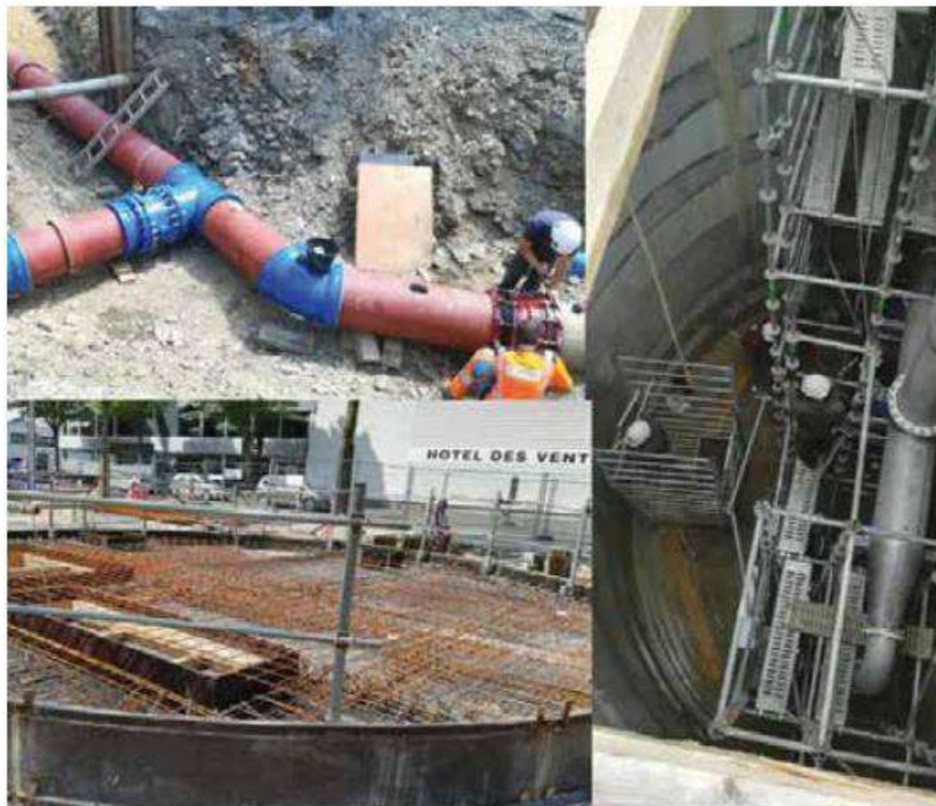
RESTRUCTURATION COMPLÈTE DU POSTE DE RELEVAGE DE LA PLACE TOUBLANC À ANGERS
