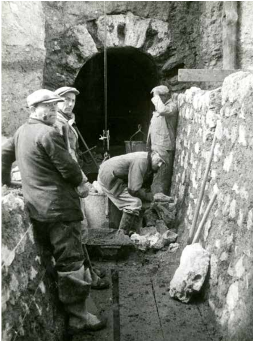
Autrefois, la réparation d'une canalisation se passait ainsi...
