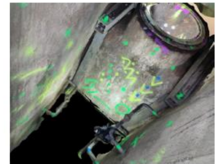
Modélisation 3D texturée au niveau d'un regard d'accès
