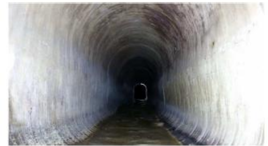
Télé-inspection de l'ouvrage
