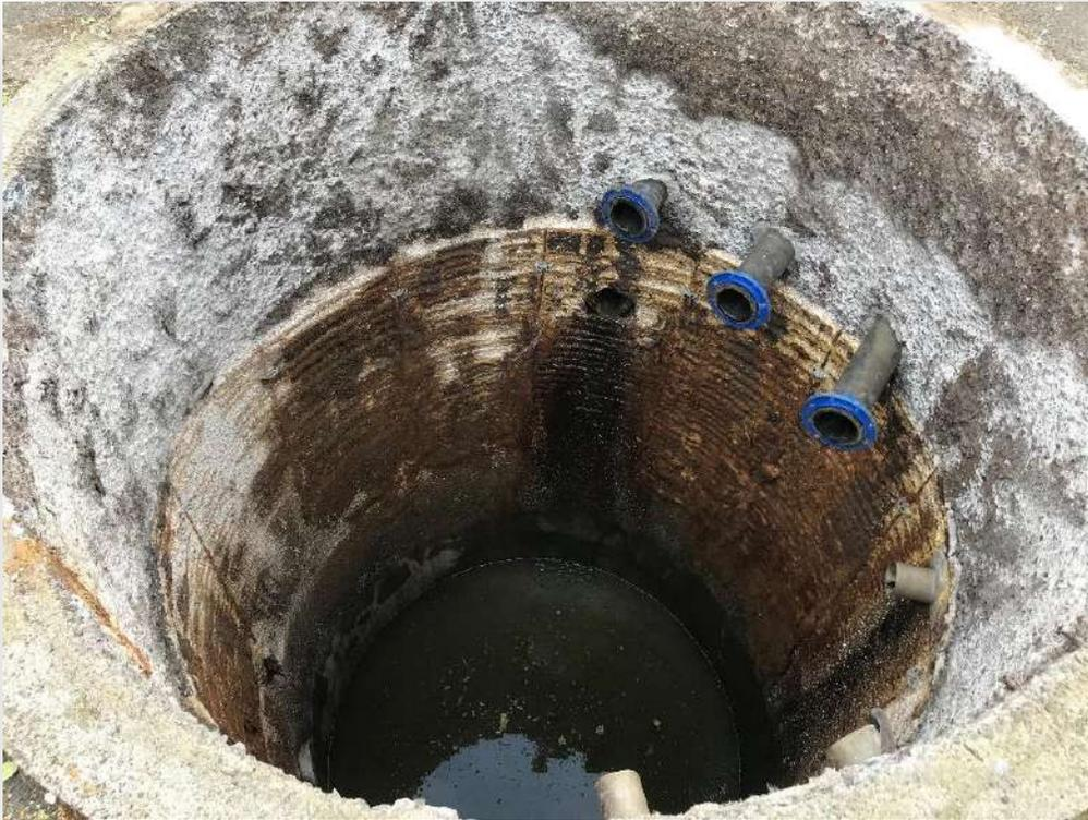
*Corrosion du béton par les effets de l' $H_2S$*
