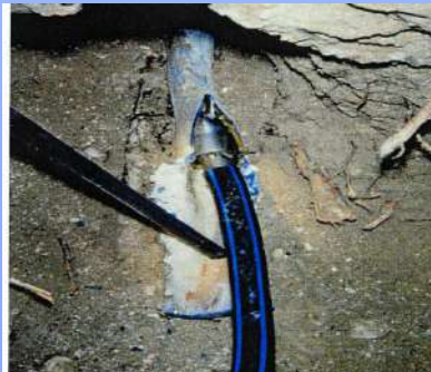
Découpe du plomb et insertion du polyéthylène à l'intérieur
