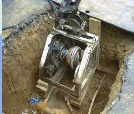
Extraction du plomb grâce à un treuil
