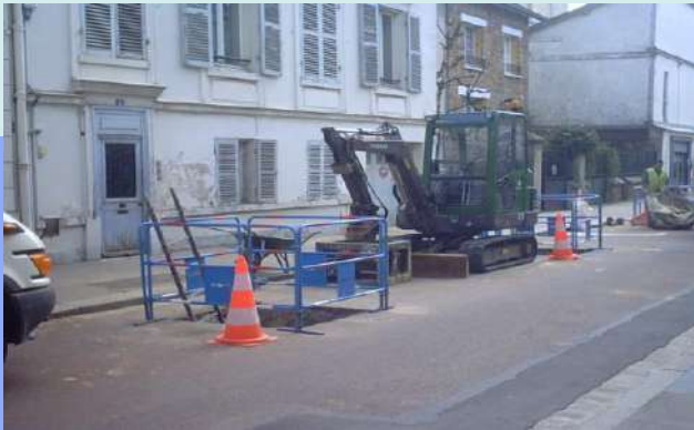
Fouille au droit de la prise du branchement à remplacer
