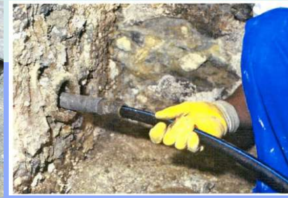
Le branchement en polyéthylène remplace en lieu et place le branchement en plomb lors de son extraction
