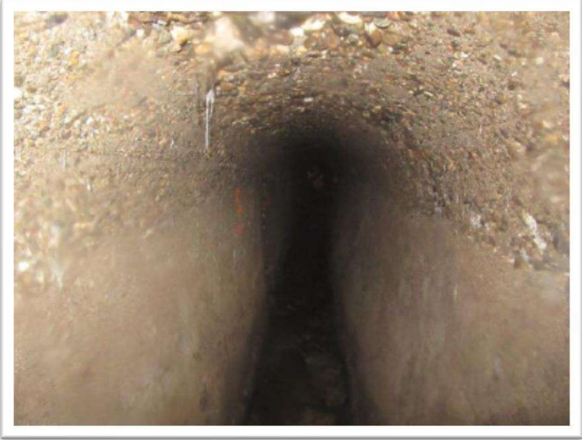
Ovoïde de section variable sous chaussée
