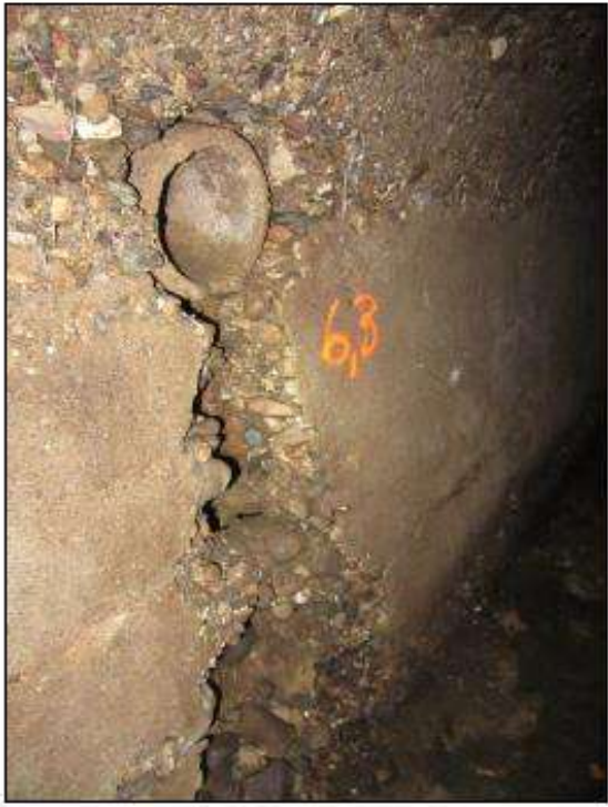
Abrasion profonde des parements
