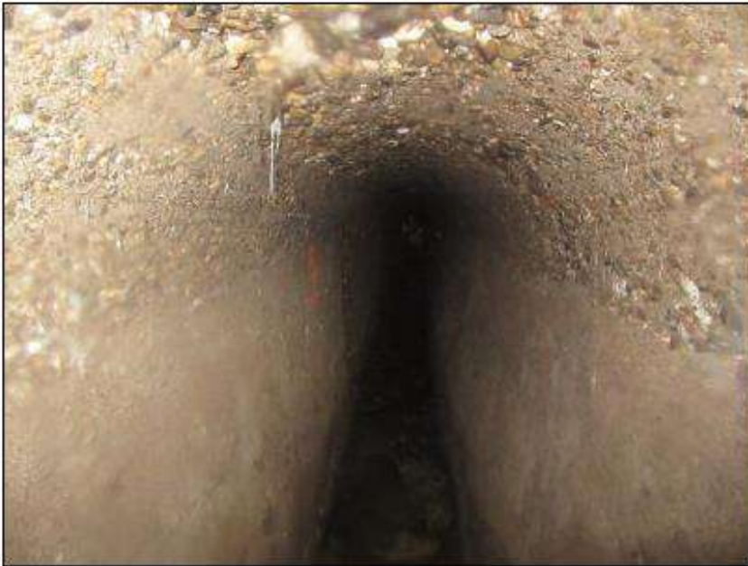
PM0 : Vue générale vers l'aval
