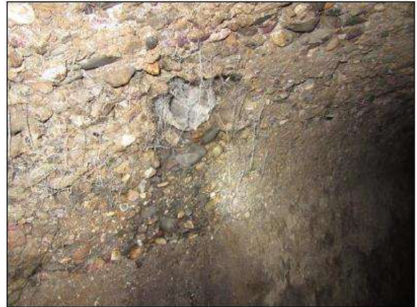
R2+16m : Vue du raccordement du branchement BR14 et granulats apparents en VG
