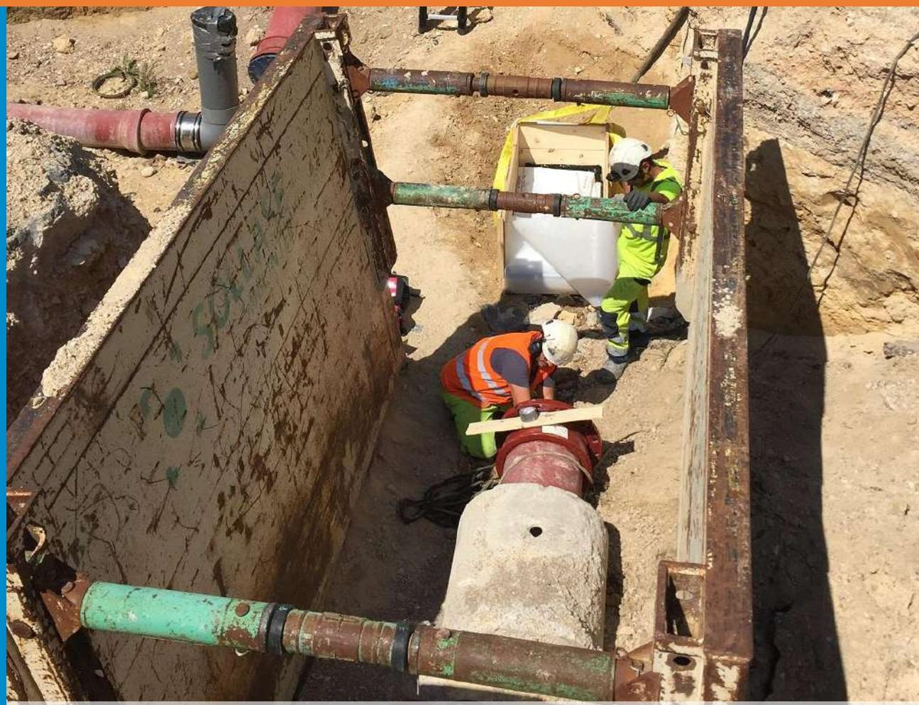
Mise en place du pre liner avant traction de la gaine
