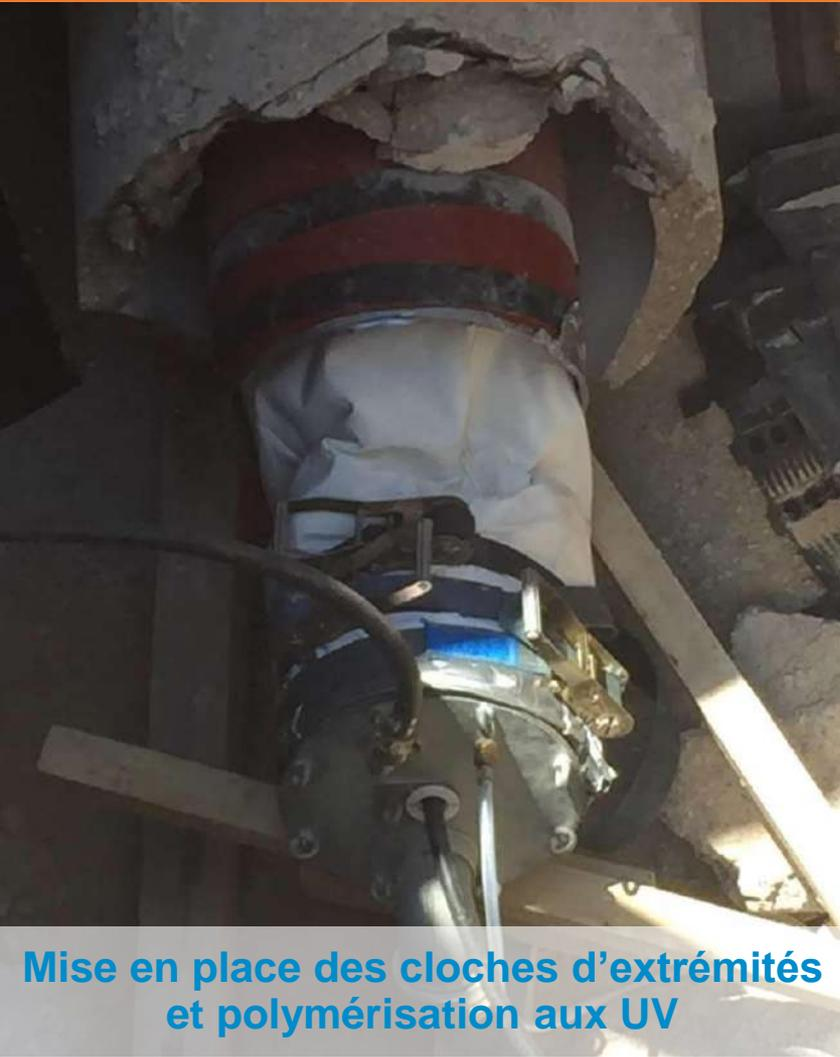
Mise en place des cloches d'extrémités et polymérisation aux UV
