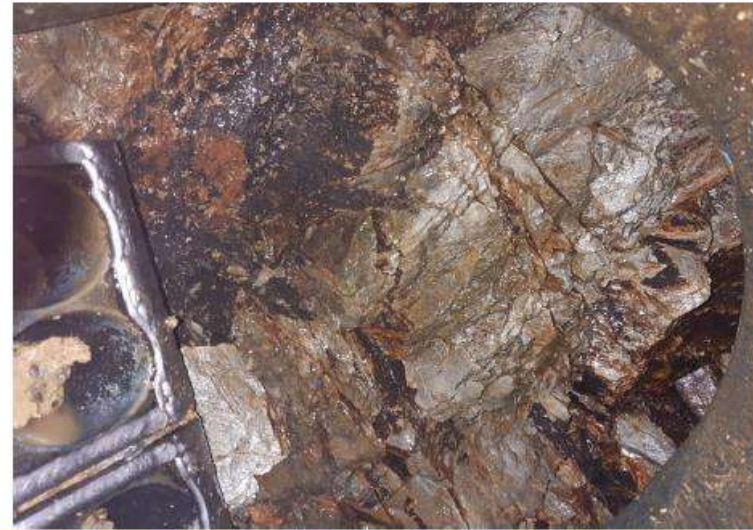
Schistes au front de taille (404,96ml)
