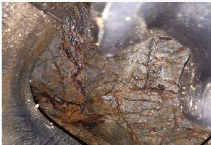
Schistes au front de taille (404,96ml)
