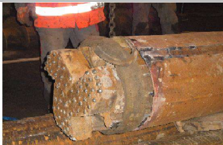
Marteau CS-112 en phase de positionnement dans le fourreau acier
