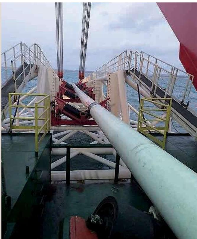
C'est à partir d'une énorme barge au large que la canalisation est tirée jusqu'au rivage.
