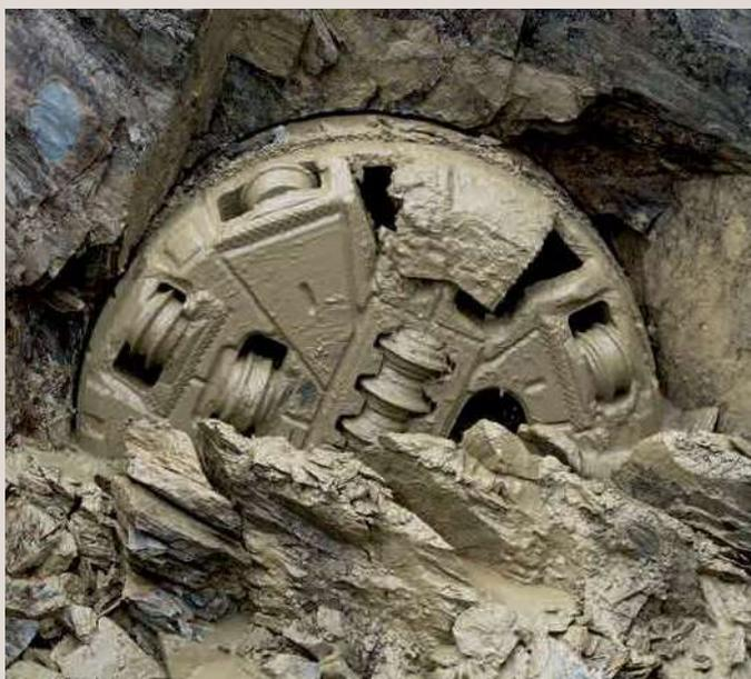
Après 20 semaines de creusement à une cadence de 6 à 7 m/j, et malgré des aléas qui ont réclamé une belle dose de sang-froid, le tunnelier a fini par atteindre son puits de sortie et exhiber sa roue de coupe « roche » achetée par la Sade pour l'occasion.
