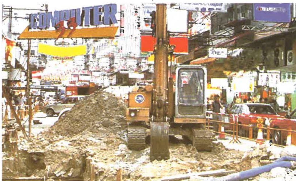
Pose de canalisation sous voirie avec ouverture de tranchée
