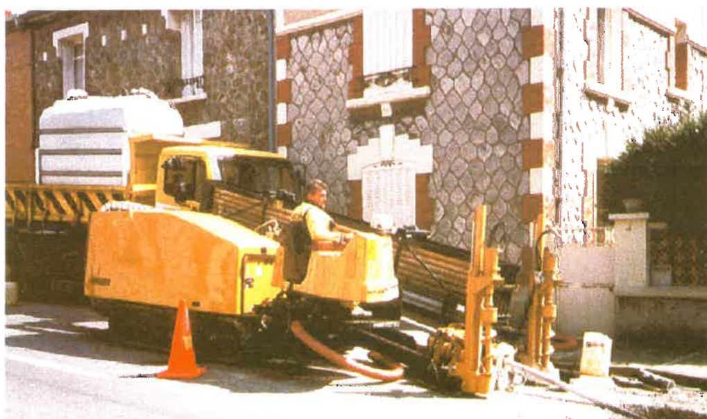
Pose de canalisation sous voirie par forage dirigé
