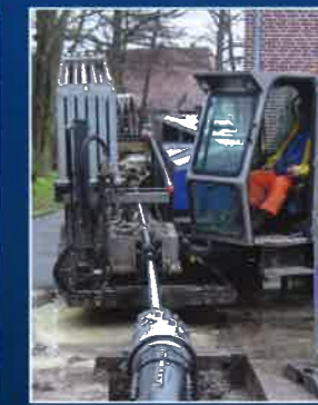
GRUNDODRILL - Forages dirigés horizontaux
