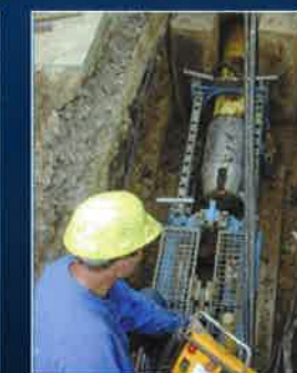
GRUNDOBURST - Eclatement - TIP - Swagelining
