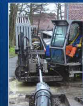
GRUNDODRILL - Forages dirigés horizontaux
