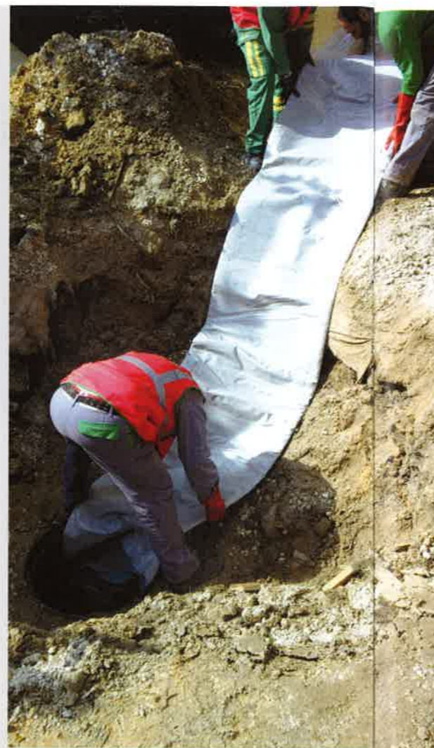
La technique de la réhabilitation par chemisage a permis de travailler vite tout en optimisant le budget du SMAROV.
