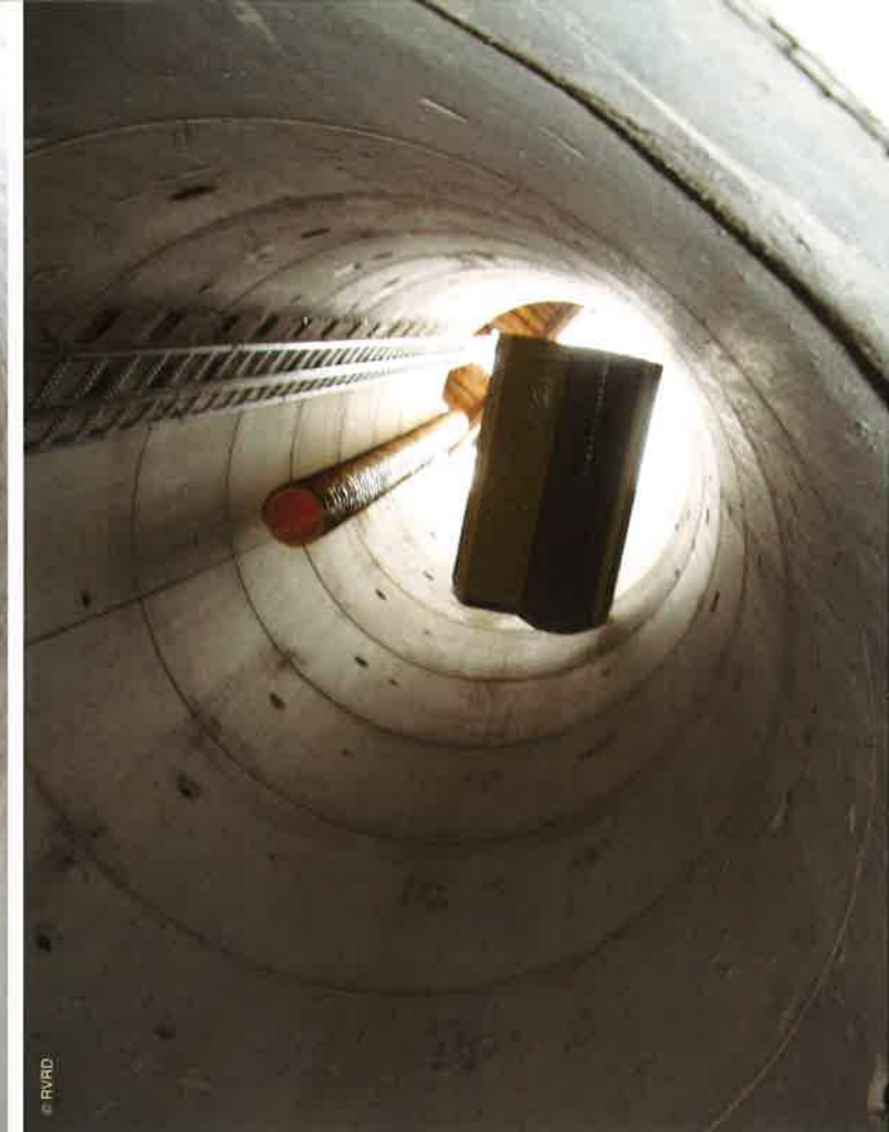
Puits de 20 m de profondeur.
