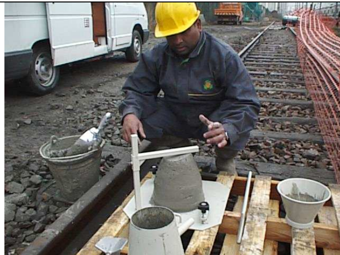
Contrôle sur béton frais d'une coque armée en béton projeté
