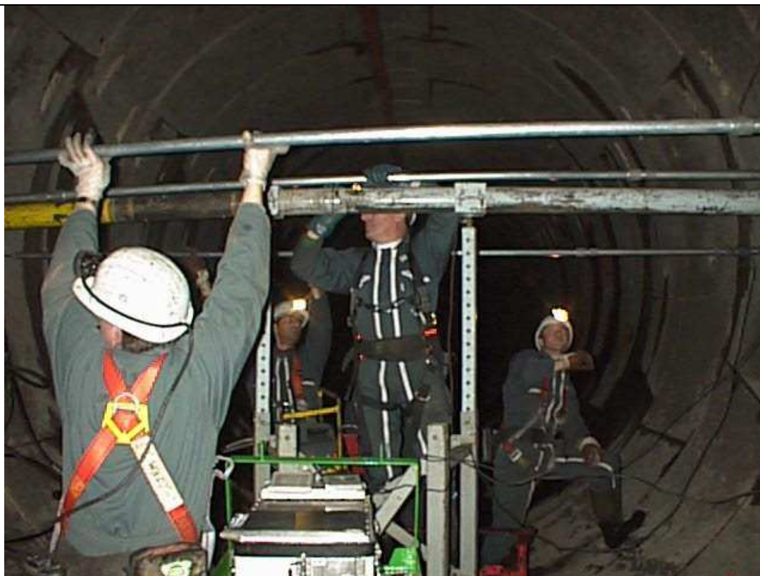
Auscultation mécanique d'un ouvrage visitable Ø4500
