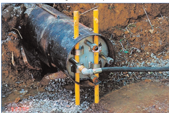
Curage à l'air comprimé
