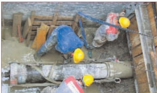
Le pousse-tubes en action dans la fouille de départ.
